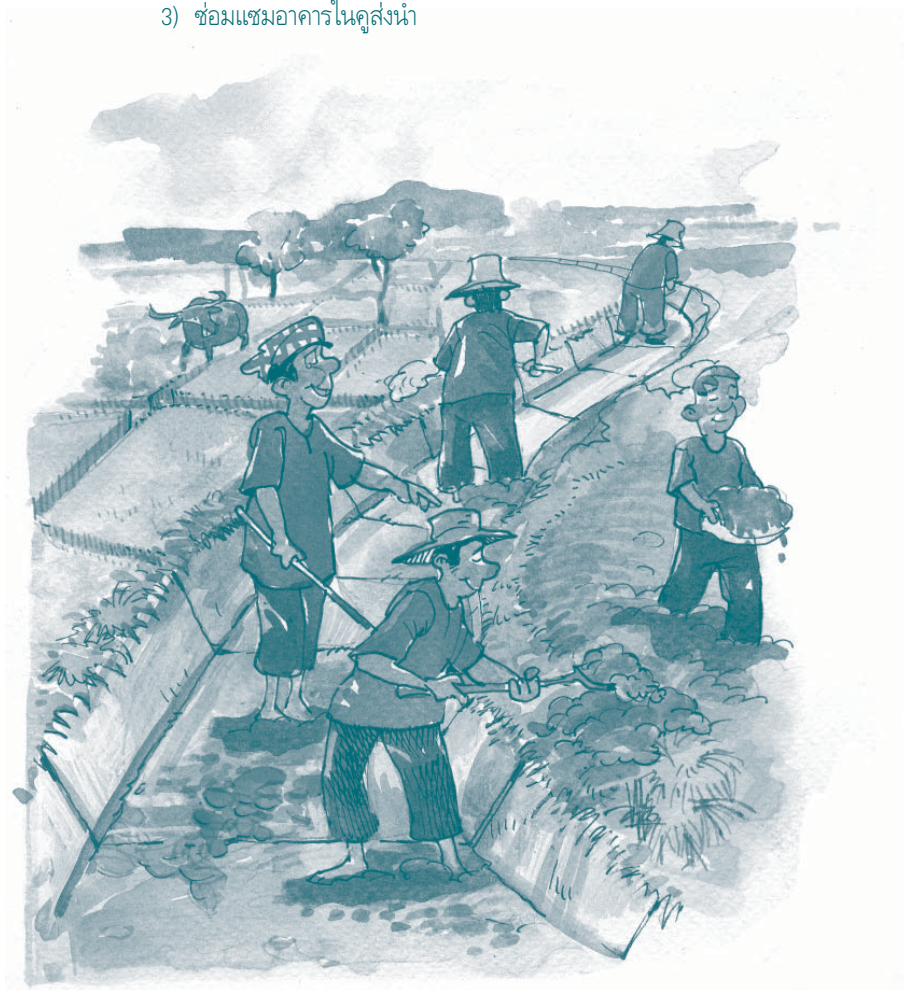
รูปที่ 6.3 เกษตรกรช่วยกันซ่อมแซม ขุดลอกตะกอนดินคูส่งน้ำ
